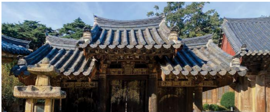
7) 솟을대문(솟을大門)의 일종. 가마를 타고 출입할 수 있도록 좌우 행랑보다 높게 설치한 대문. 가운데 칸을 높여 만든 것을 솟을삼문이라고 한다.
